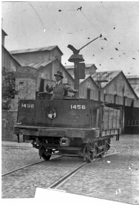
10. Góndola eléctrica para el servicio de carga, ca. 1920. SINAFO-INAH, 135873.
