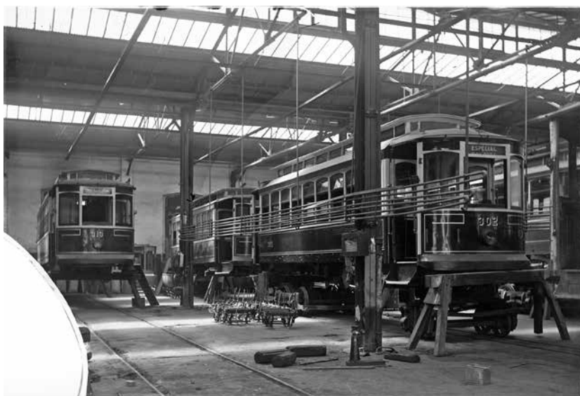
7a y b. Dos vistas del interior de los talleres de pintura de la Compañía de Tranvías de México ubicados en Indianilla, actualmente colonia de los Doctores, Ciudad de México, ca. 1910. SINAFO-INAH, 135837, 135834.
