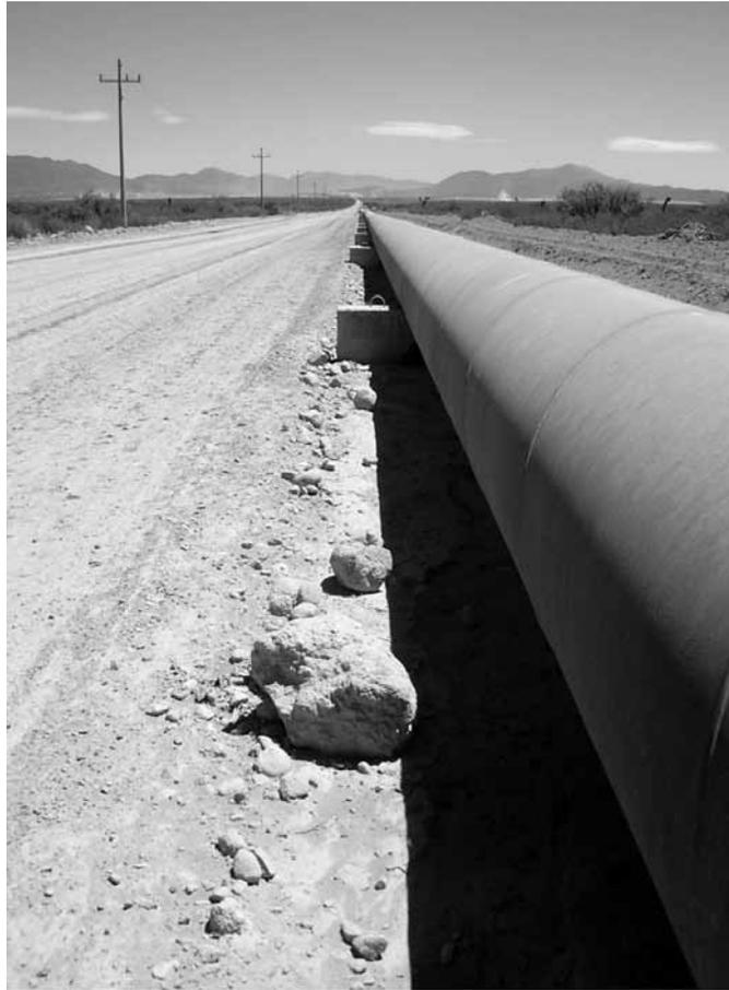
Fig. 6 Conducto de tubería para el transporte de las aguas de los pozos hasta la planta de procesamiento de los metales (foto Pánico).
