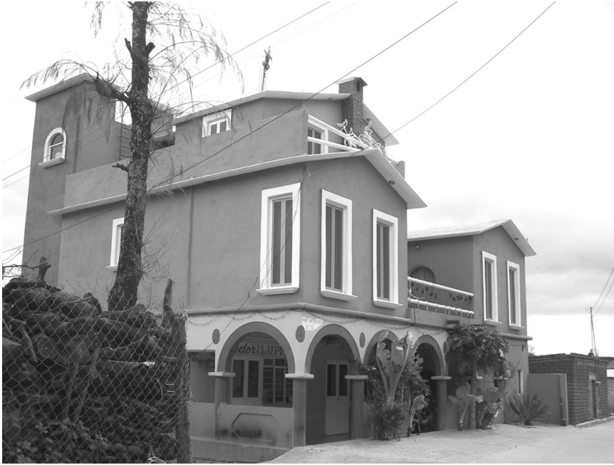
Fig. 5. Vivienda cercana a Coixtlahuaca, en el antiguo camino hacia Nochistlán, Oaxaca (Foto: G. Boils, diciembre de 2008).
