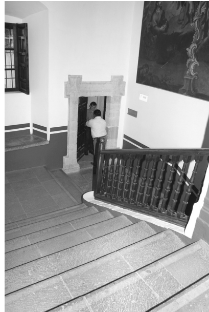
Fig. 6. Escalera hacia el refectorio.
